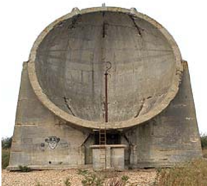
Акустический локатор (тарелка) диаметром 10м на полуострове Кент, Англия. Построен в 1928г. Современный снимок.
